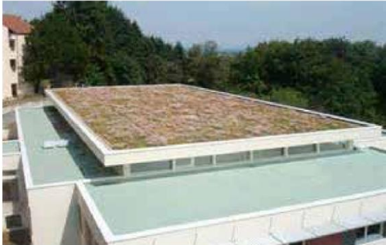
La toiture terrasse joue le rôle à la fois d'isolant thermique ou de rétention d'eau en cas de plantation semi-intensif ou intensif
