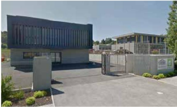
Portail en béton coulé en place avec modénature
